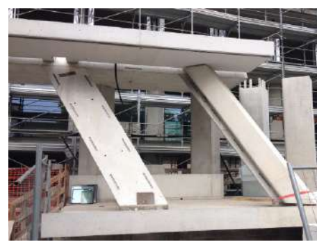
Rivestimento dei pilastri - Fond. Feltrinelli Milano Revêtement des piliers - Fond. Feltrinelli Milan-Italie
