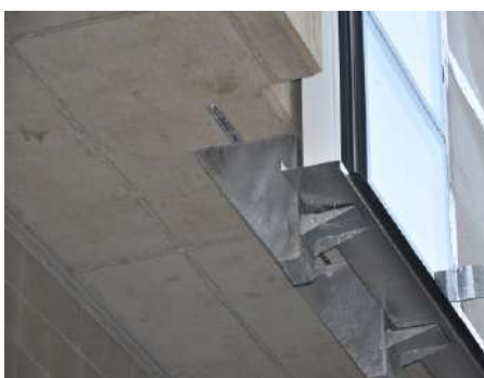
Facciata in vetro - Reale Mutua Assicurazioni Torino Façade en verre - Reale Mutua Assicurazioni, Turin-Italie
