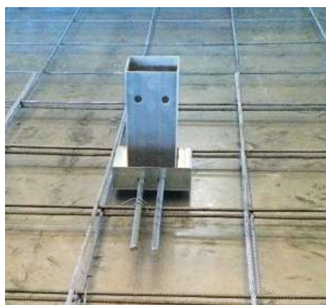
Fondo cassero Fond de coffrage
