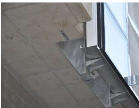
Facciata in vetro - Reale Mutua Assicurazioni Torino Curtain walling - Reale Mutua Assicurazioni, Turin-Italy
